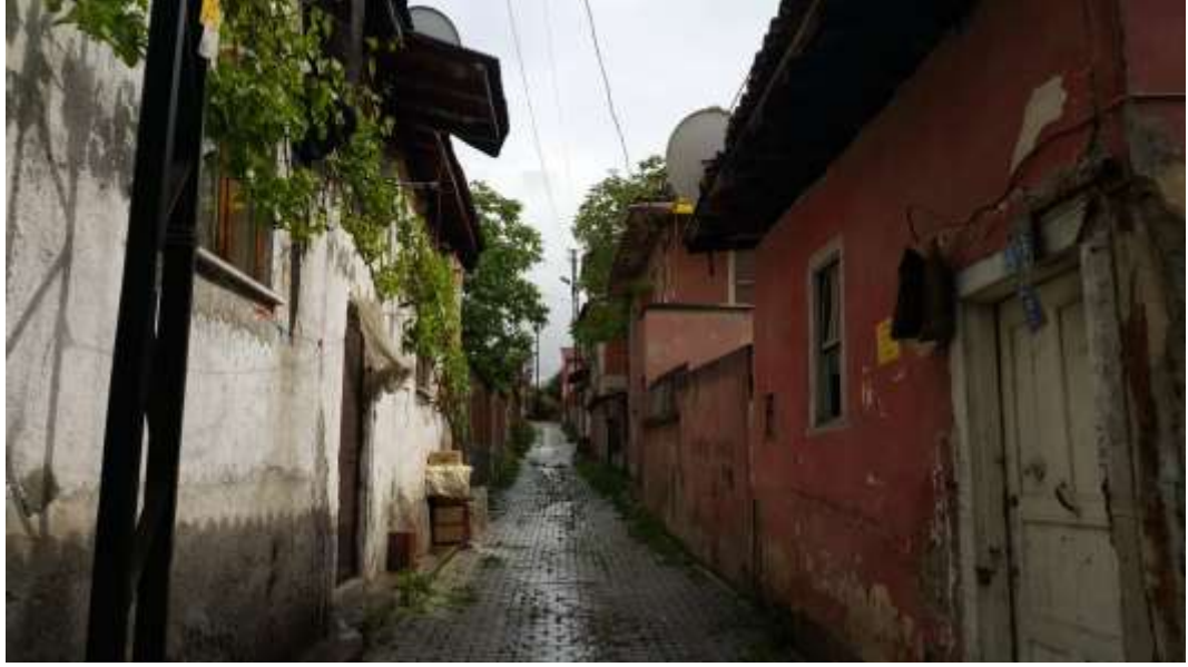
Şekil 4.12. Vezirköprü Kentsel sit alanında bulunan zarar görmüş bazı ev görünümleri
