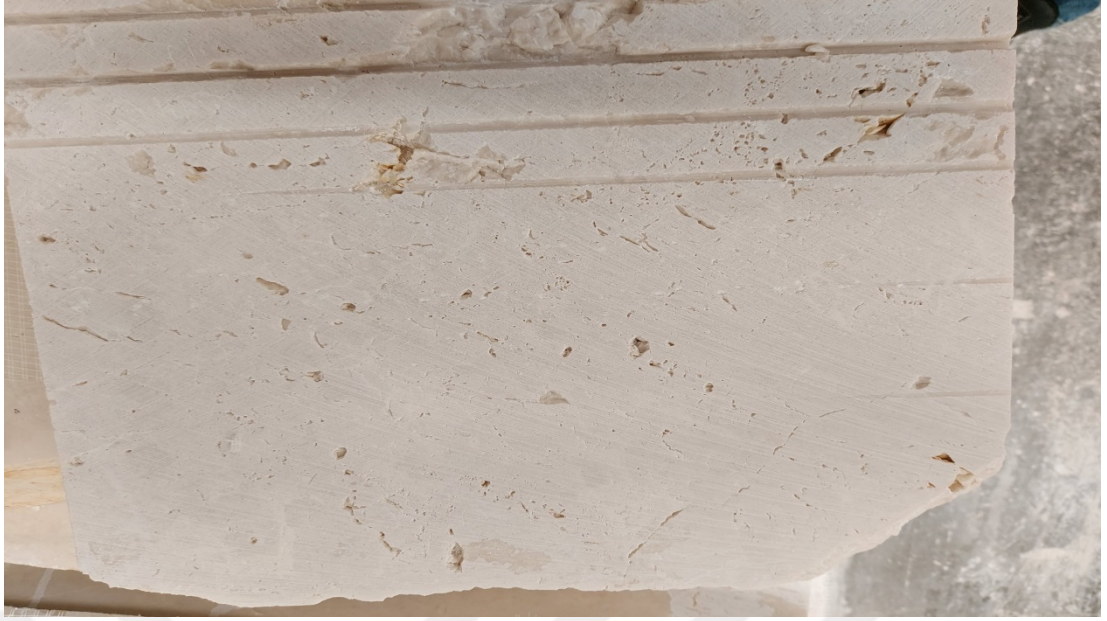
Şekil 1.2. Kırık-çatlak sistemlerinin genel görünümü
