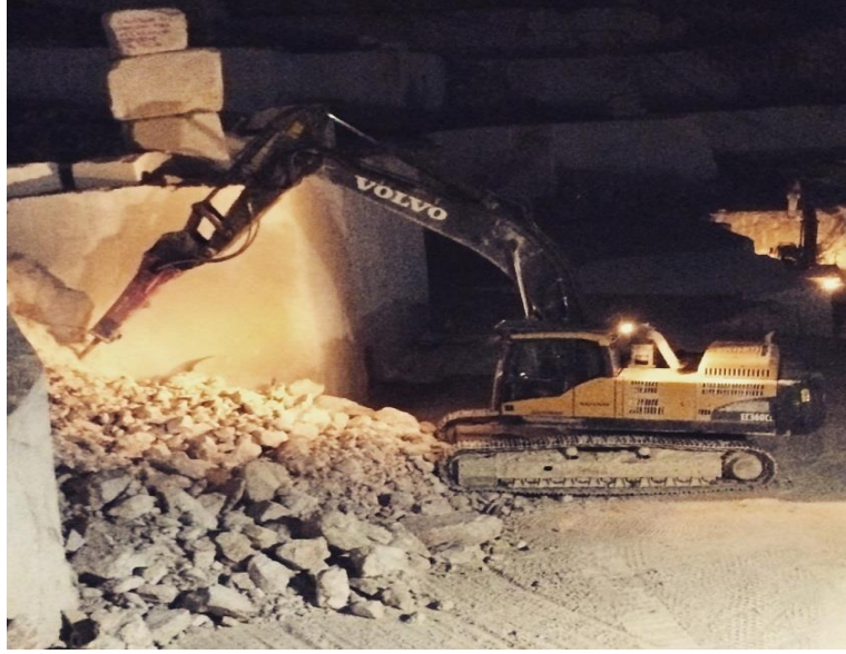
Şekil 3.11. Hidrolik kırıcı ile söküm işlemi
