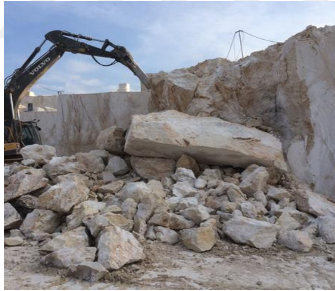
Şekil 4.14. Gevşetme sonrası hidrolik kırıcı ile kırma işlemleri
