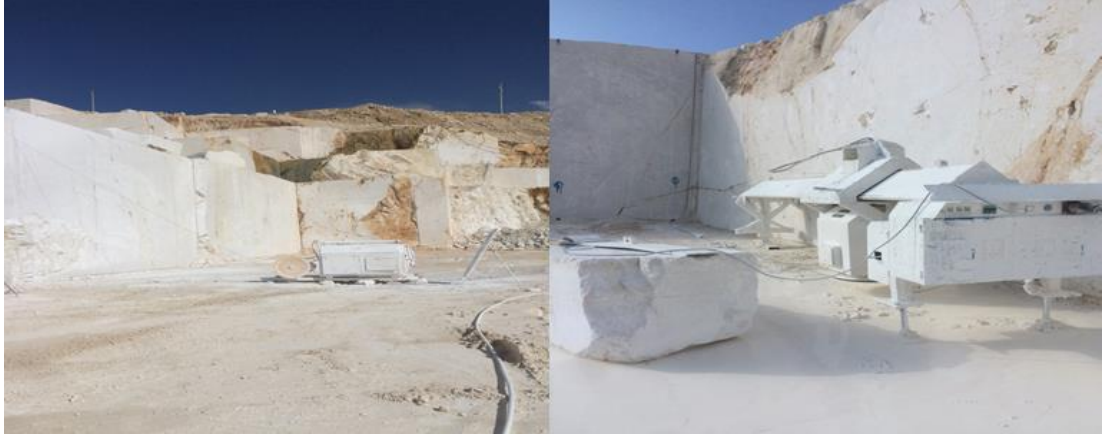
Şekil 4.4. Söküm yapılacak bölgelerin alt ve yan kesimlerinin yapılması
