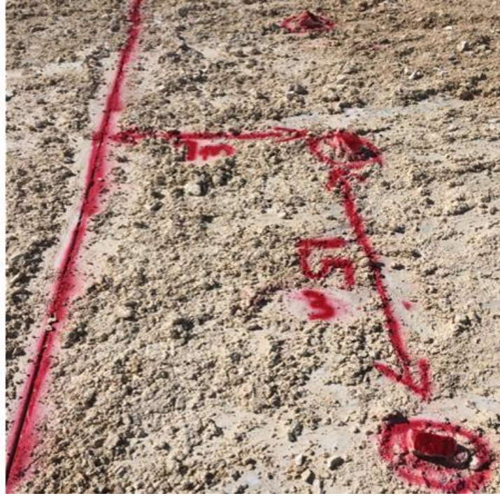
Şekil 4.7. Dilim kalınlığı ve delikler arası mesafe
